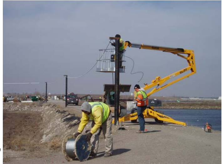
Project "Eau de Toilette"
